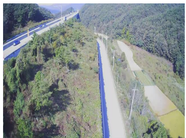
상부 성토부 전경
